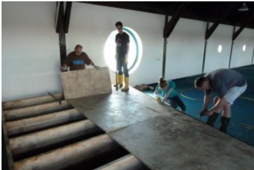
werden die Bauschäden (im Bild unsere Bühne, bei der der Belag komplett getauscht werden muss) erst jetzt so richtig deutlich.
